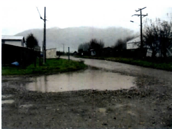
Fotografía N° 3: Baches en intersección de calles Pangal con Bernardo O'Higgins, en la ciudad de Puerto Aysén.
