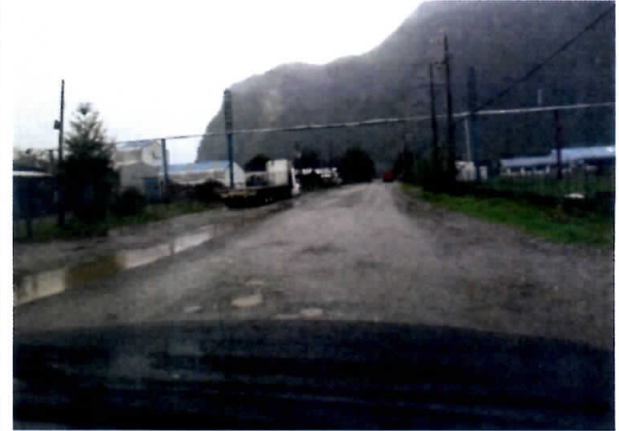
Fotografía N° 2: Baches en calle Pangal, en la ciudad de Puerto Aysén.
